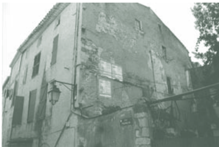
Antes del proyecto de rehabilitación
