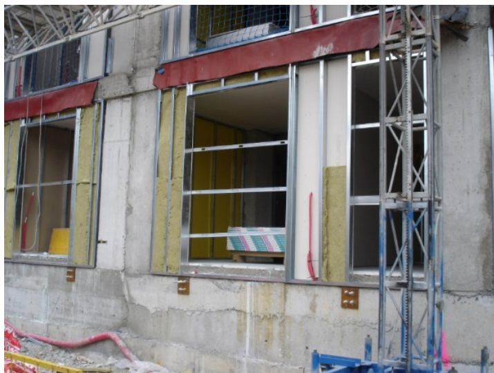
Fase de ejecución de la fachada ventilada.
