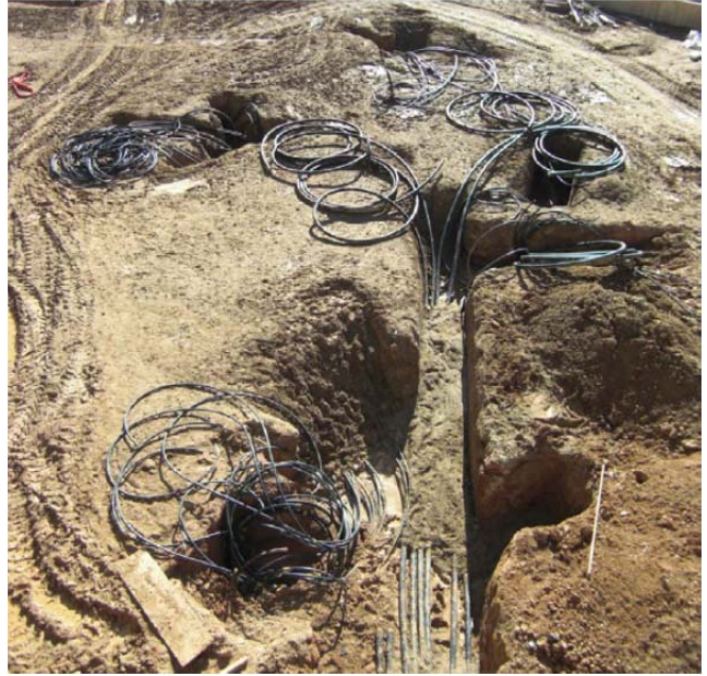
Instalación geotermia: tubos en pozos.
