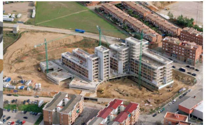
Vista aérea en fase de construcción
