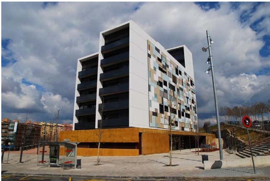
Fachada Sur y fachada Este.
