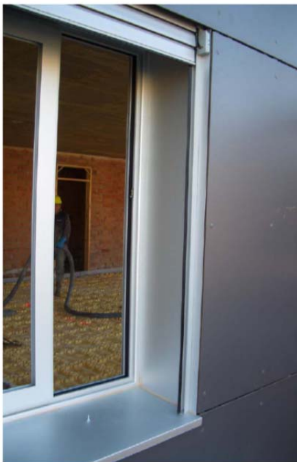
Ventana acabada con las persianas enrollables de lama orientable motorizadas y sección de la fachada por la ventana.
