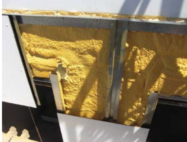
Fachada ventilada en construcción.
