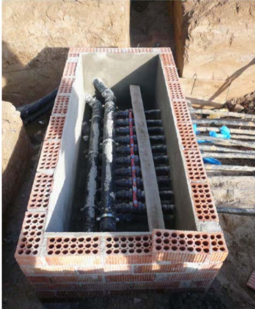
Instalación geotermia: arqueta.
