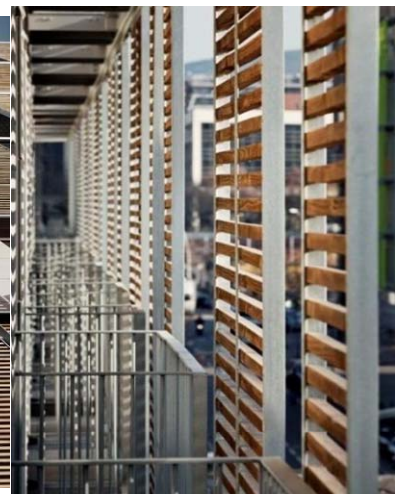
Detalle protecciones solares
