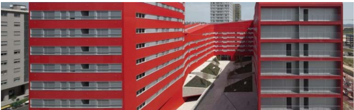
Huecos en la fachada Sur
