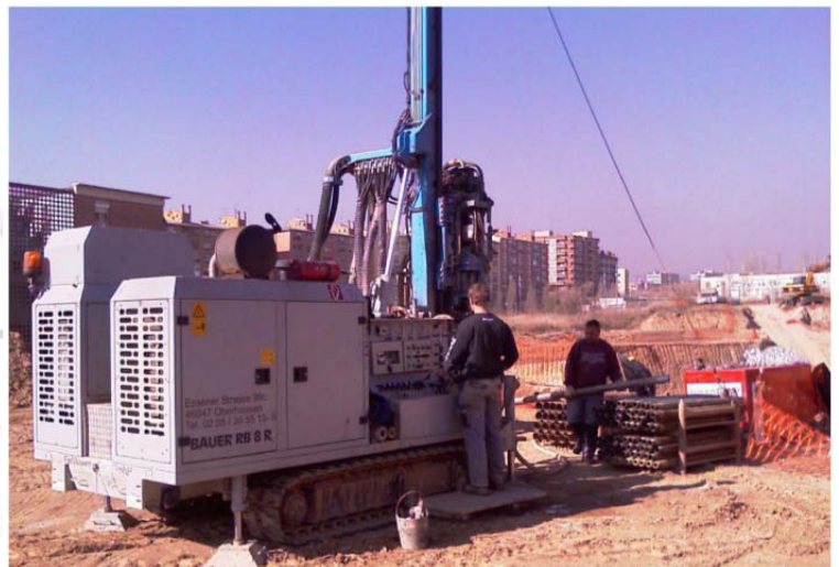
Instalación geotermia: perforación de los pozos.
